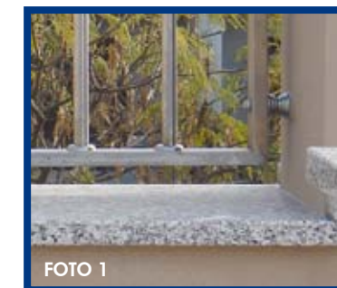
FOTO 1: DETAGLIO FISSAGGIO LATERALE PARAPETTO INOX FOTO 2: DETAGLIO FISSAGGIO AD ANGOLO
