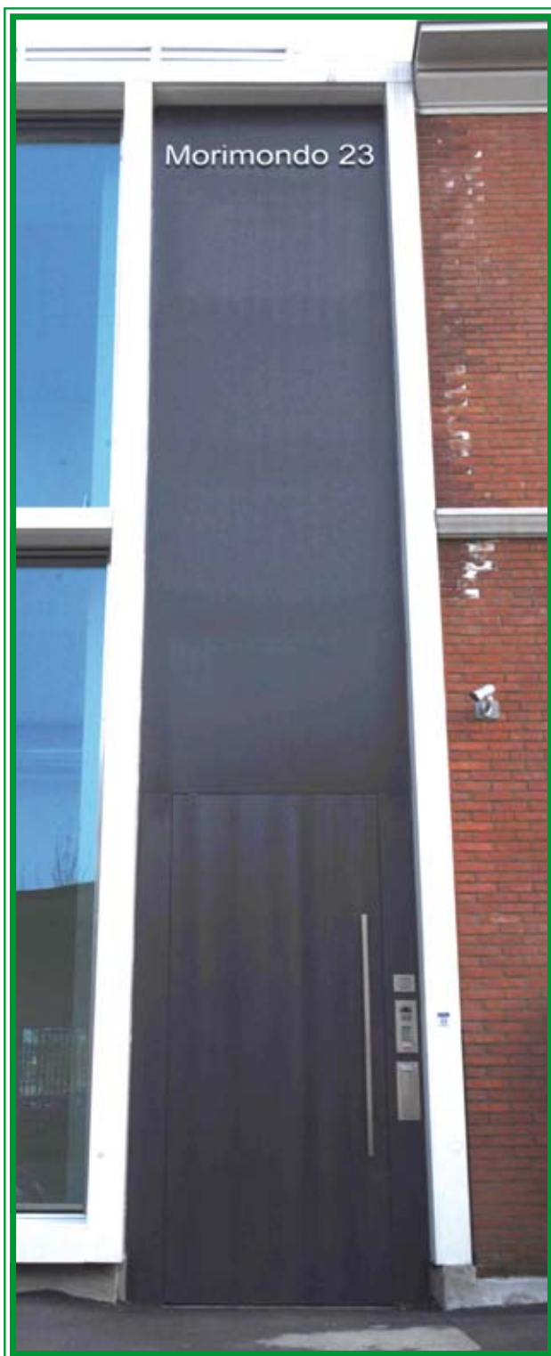
PORTONE IN FERRO ALTO 8 mt CON PROFILO FORSTER, PORTA A SCOMPARSA E SCRITTA IN ACCIAIO LASERATA
