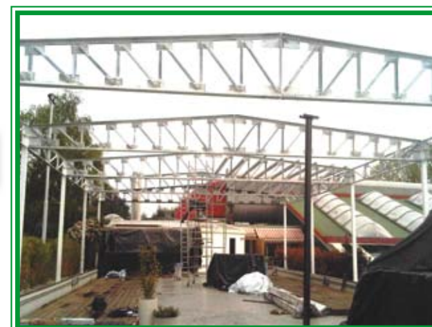
FASE DI MONTAGGIO DI ARCARECCI IN ANGOLARE BULLONATI PER STRUTTURA ESTERNA
