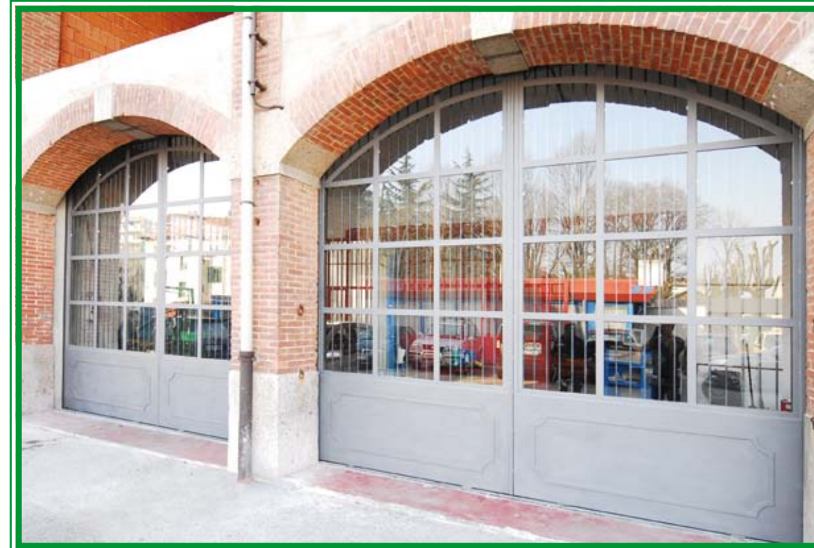
PORTONI SCORREVOLI IN FERRO AD ARCO REALIZZATI PER AUTOFFICINA CON INFERRIATE INTERNE APIBILI SU CERNIERE
