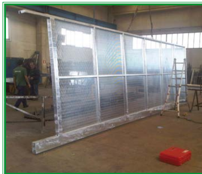
REALIZZAZIONE DI CANCELLO IN FERRO SCORREVOLE SCHERMATO L 10 mt PER F.S.
