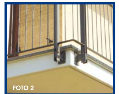
FOTO 1: DETAGLIO FISSAGGIO LATERALE PARAPETTO INOX FOTO 2: DETAGLIO FISSAGGIO AD ANGOLO
