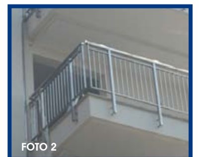
FOTO 1: FISSAGGIO PIANTE A PERNO SENZA PIASTRE FOTO 2: PARAPETTO INOX CON FISSAGGIO NELLA PIANTE A SCOMPARSA
