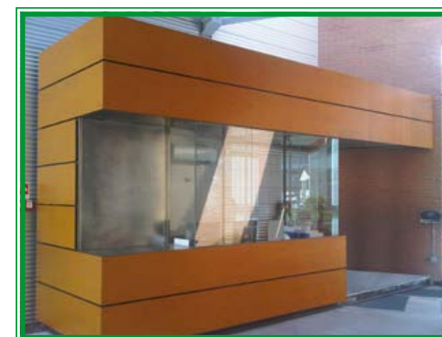
GUARDIANA NOTTURNA IN FERRO POSATA E RIVESTITA IN PARKLEX E COMPLETA DI VETRI
